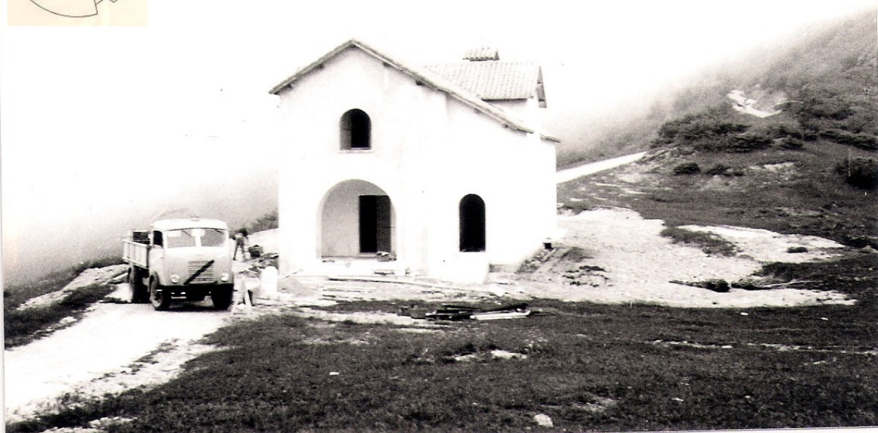
5. Cappella in Costruzione
