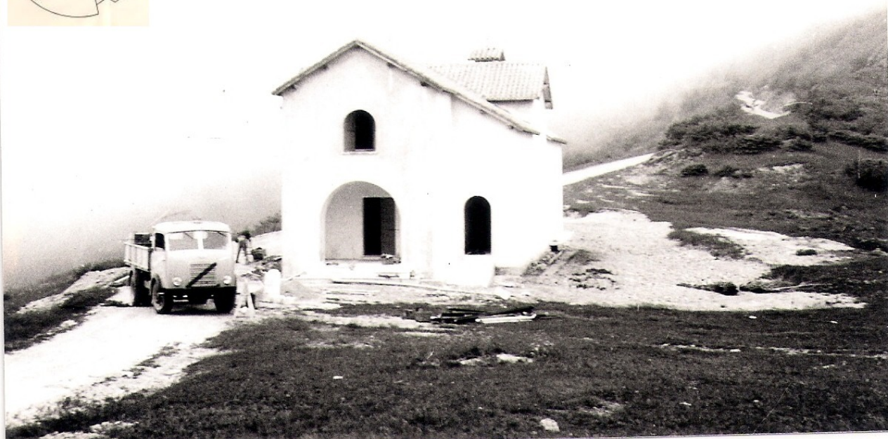
5. Cappella in Costruzione
